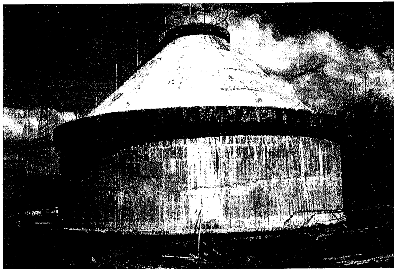
4. kép Az iszaprohasztó javítás előtt
