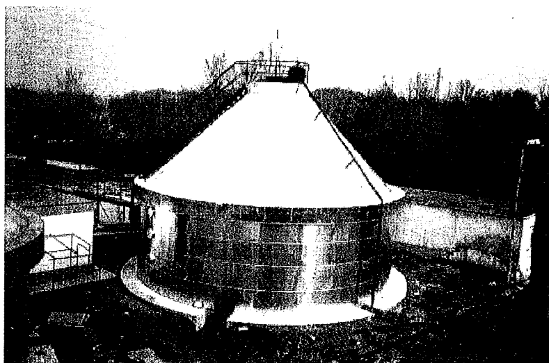
5. kép Az iszaprohasztó javítás előtt
