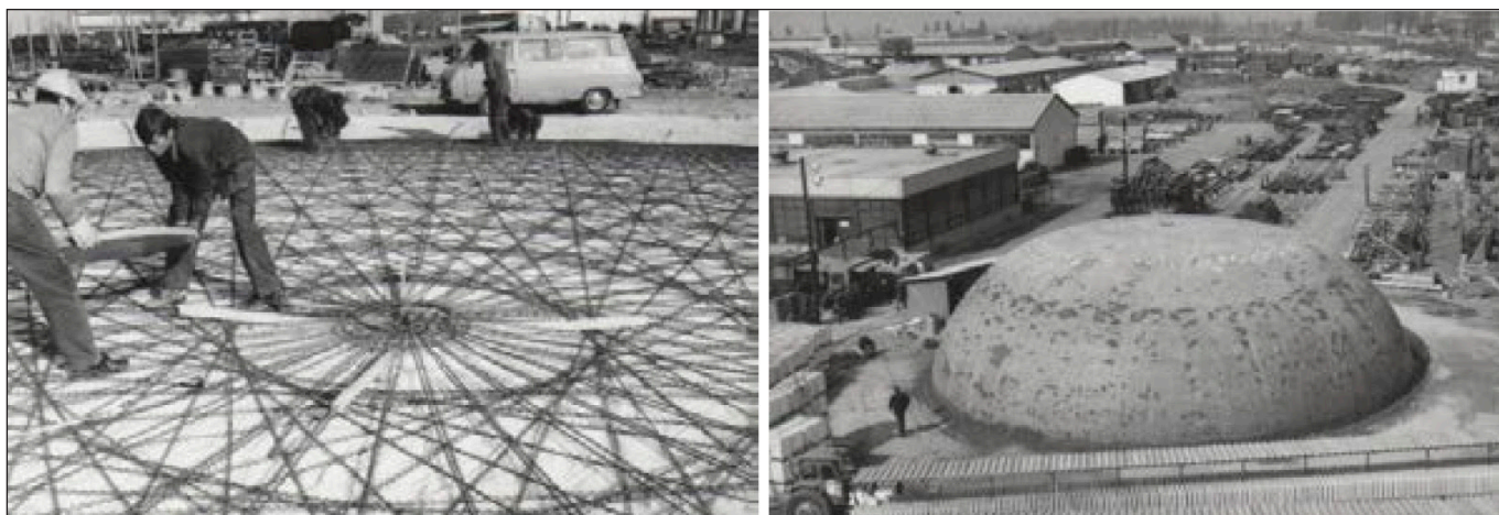
2. ábra: Binishell kupola vasszerelése a földön, majd felfújva az ARÉV ipari telepén
