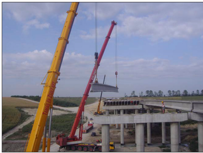
3. ábra: Völgyhíd építése az M6 autópályán
