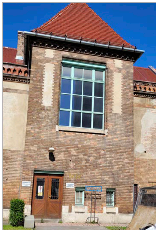
3. ábra: Az „MM” épület bejárata az udvar felől
